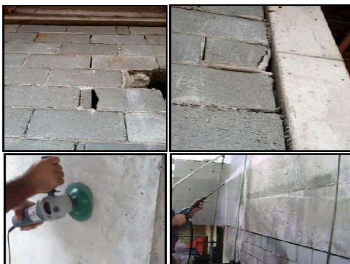
Figura 8 – Serviços de tratamento da fachada
