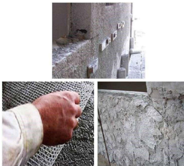
Figura 10 – Mapeamento de fachada, taliscamento, colocação de tela e 1º cheia de massa
