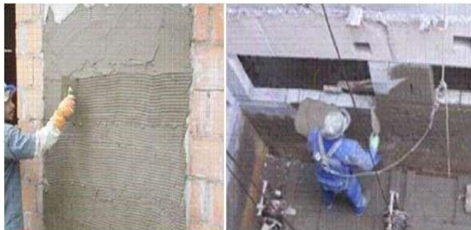
Figura 9 – Aplicação de chapisco convencional e industrializado
