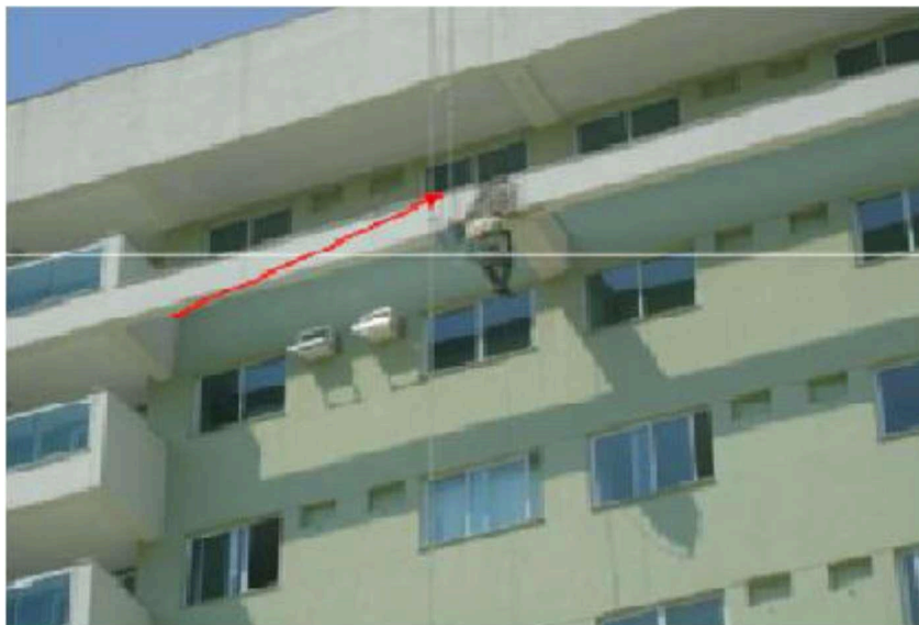
Figura 24 – Reparo das trincas com o auxílio de cadeirinha
