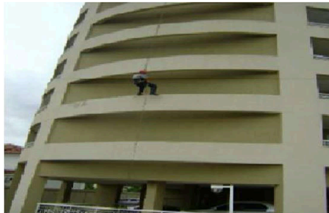
Figura 18 – Reparos das trincas e deslocamento de argamassa com auxílio de cadeirinha
