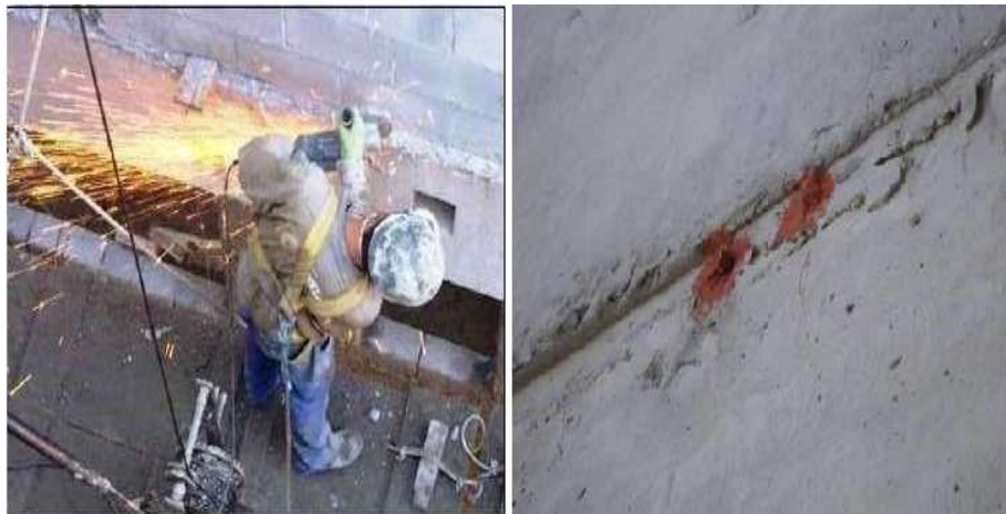
Figura 7 – Remoção de resto de aço da estrutura e ganchos e tratamento
